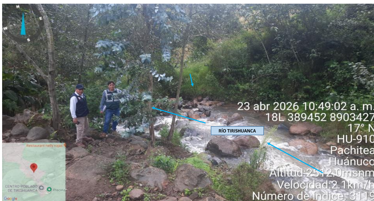
IMAGEN 03: EN ESTE TRAMO SE OBSERVA EN AMBAS MÁRGENES DEL RÍO TIRISHUANCA, QUE SE ENCUENTRAN SIN PROTECCIÓN, Y SU CAUCE SE ENCUENTRA COLMATADO CON PIEDRAS MEDIANAS.
